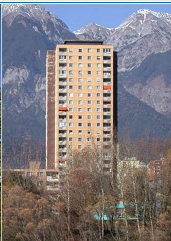
In diesem Wohnhochhaus wurden im Rahmen der Sanierung die Loggien thermisch geschlossen und in erweiterte Wohnräume und Wintergärten umgewandelt. Alle Fenster wurden ausgetauscht und sind durch Holz-Alu-Fenster mit 3-Scheibenverglasung ersetzt worden. Die Spezialkonstruktion des Außenwandaufbaues der VÖEST wurde mit 16 cm Mineralwolle zusätzlich gedämmt, Windpapier und 4 cm Hinterlüftung sowie 4 mm Alucopond-Paneele kompletieren den Fassadenaufbau.
